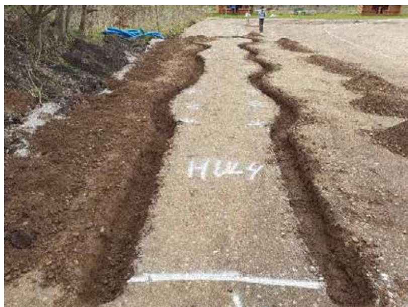
Udgravning til første bane D. 2. april 2021
