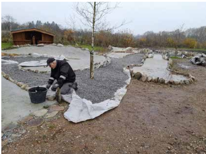
Udlægning af skærver igangsat D. 13. november 2021
